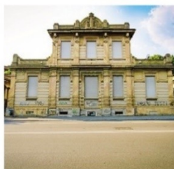
La facciata dell'edificio lungo via San Giorgio
