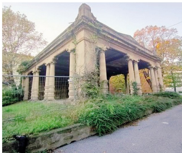
Il porticato dell'ex mercato ortofrutticolo che verrà ristrutturato per diventare una sala lettura
